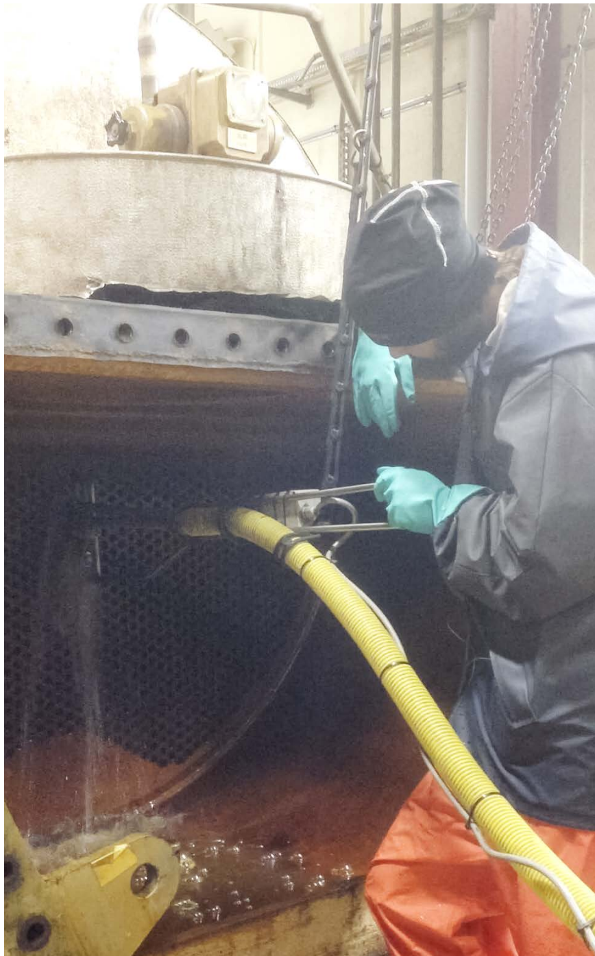
Tvätt av stora värmväxlare i samarbete med Vattenfall. Operatören fäster munstycket från roboten i hålen som ska tvättas. Därefter sker tvätt med iller som matas ut automatiskt i jämn hastighet. Operatören slipper bli nersmutsad av tvättvatten och tvättresultatet blir jämnare och bättre.
