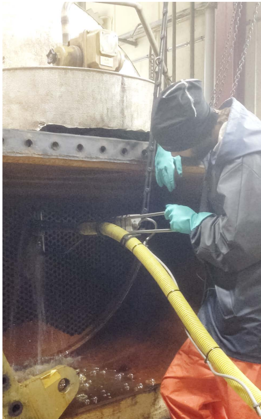
Tvätt av stora värmeväxlare i samarbete med Vattenfall. Operatören fäster munstycket från roboten i hålen som ska tvättas. Därefter sker tvätt med iller som matas ut automatiskt i jämn hastighet. Operatören slipper bli nersmutsad av tvättvatten och tvättresultatet blir jämnare och bättre.
