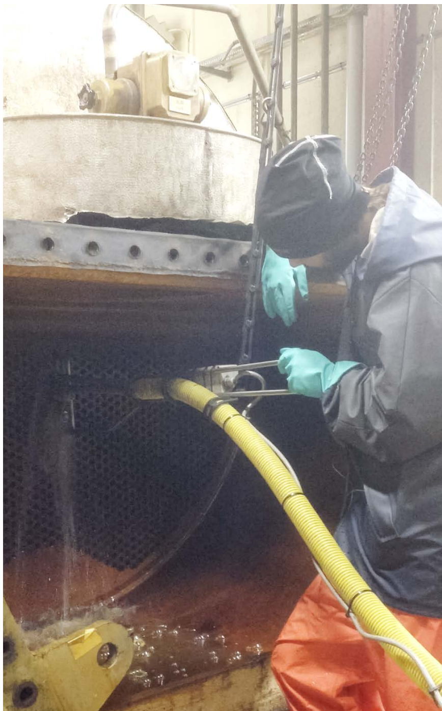
Tvätt av stora värmeväxlare i samarbete med Vattenfall. Operatören fäster munstycket från roboten i hålen som ska tvättas. Därefter sker tvätt med iller som matas ut automatiskt i jämn hastighet. Operatören slipper bli nersmutsad av tvättvatten och tvättresultatet blir jämnare och bättre.
